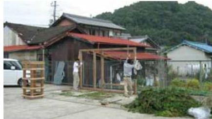
06 オカリヤ解体後
